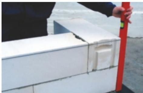
Очередной ряд кладки начните с углов, при этом необходимо помнить о правиле перевязывания элементов. Смещение последующего ряда блоков относительно предыдущего должно составлять не менее 8-12 см. Угловые блоки с максимальной точностью уложите на слой кладочной смеси. Их положение контролируйте при помощи уровня и при необходимости корректируйте резиновой киянкой.
