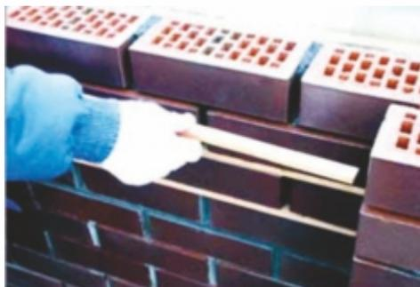
дистанцирующие планки шириной около 15 мм и высотой, равной высоте горизонтальных швов. Планки располагайте так, чтобы они соприкасались с внешней поверхностью стены. Подготовленную смесь при помощи кельмы нанесите между дистанцирующими планками, подобно тому, как при кладке «с заполненными швами». Очередные слои кирпича необходимо укладывать точно по уровню шнура-причалки, растянутого между вертикальными рейками и обозначающего среднюю высоту слоя.
