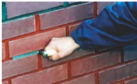
После полного высыхания кладочной смеси (примерно 7 дней) приступаем к заполнению швов специальной затирочной смесью КРАЙКА-19/29. Подготовку смеси к применению произведите в соответствии с инструкцией на упаковке. Готовый к использованию раствор затирочной смеси должен иметь консистенцию «мокрой земли». Цвет
