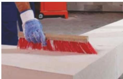
После укладки первого ряда блоков обязательно отшлифуйте верхнюю поверхность кладки (как и каждого последующего) с помощью специальной выравнивающей терки, с целью выравнивания и улучшения сцепления раствора с блоками. Мелкие частицы и пыль, образовавшиеся в результате шлифования необходимо тщательно очистить щеткой.
